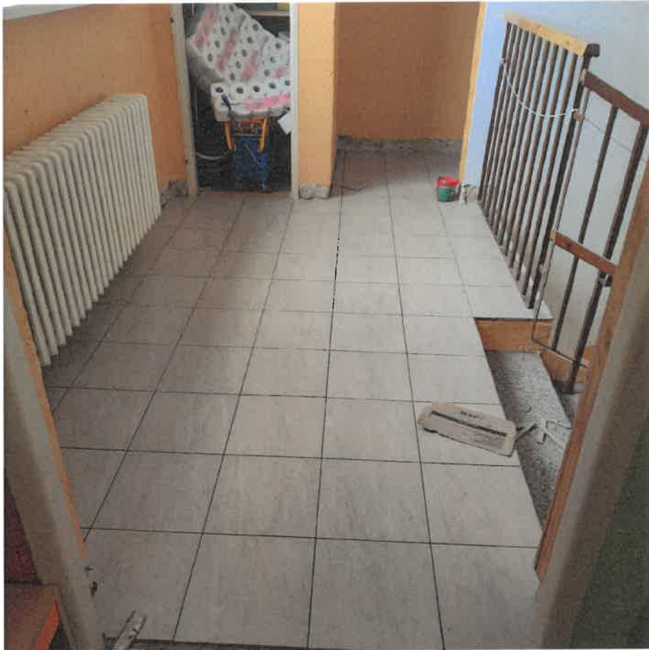
„Průběh rekonstrukce v MŠ“
