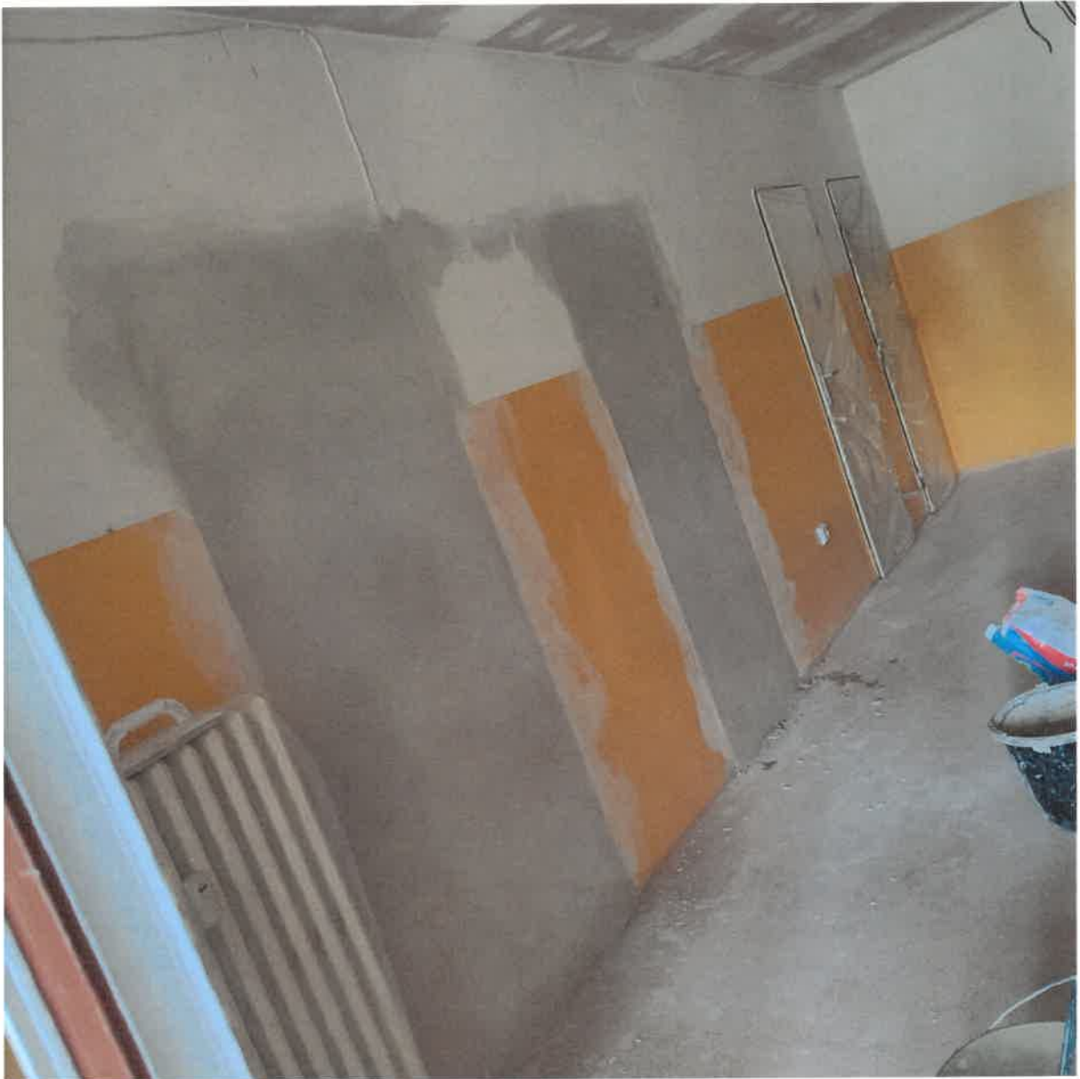
„Rekonstrukce ve středisku“
